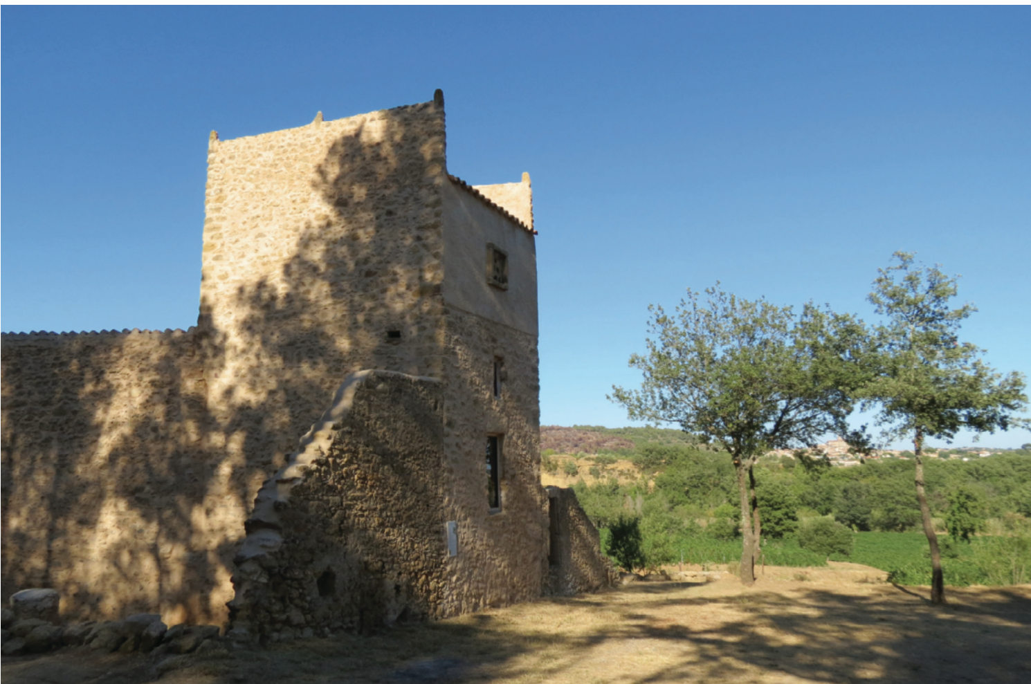
A l'ouest de Murviel-lès-Béziers : le pigeonnier d'Yvernès (cliché Guilhem Beugnon)
