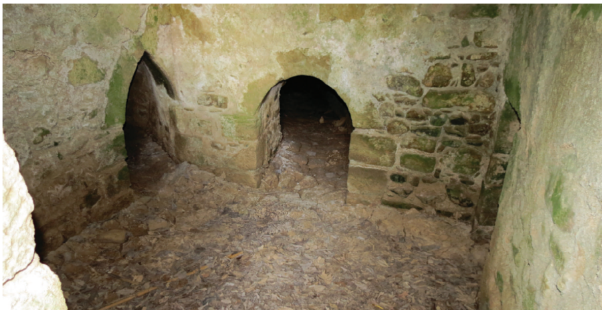
Bassin de captation, galeries de captation (à gauche et en face) et galerie de recueillement (à droite) (cliché G. Beugnon)
