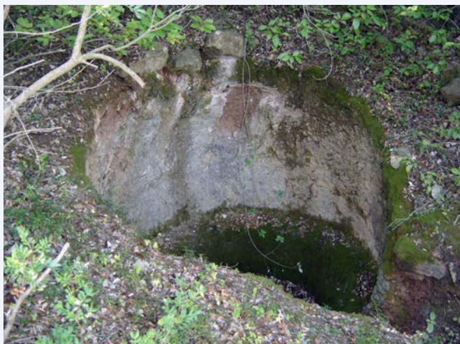
Cuve et départ du conduit d'aération du four n° 1
